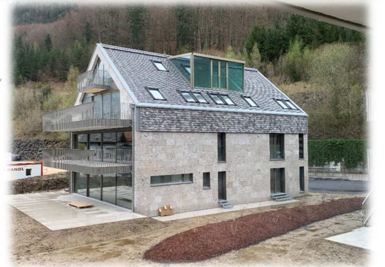
Die Bauarbeiten (Haus C) kurz vor dem Abschluss.....
