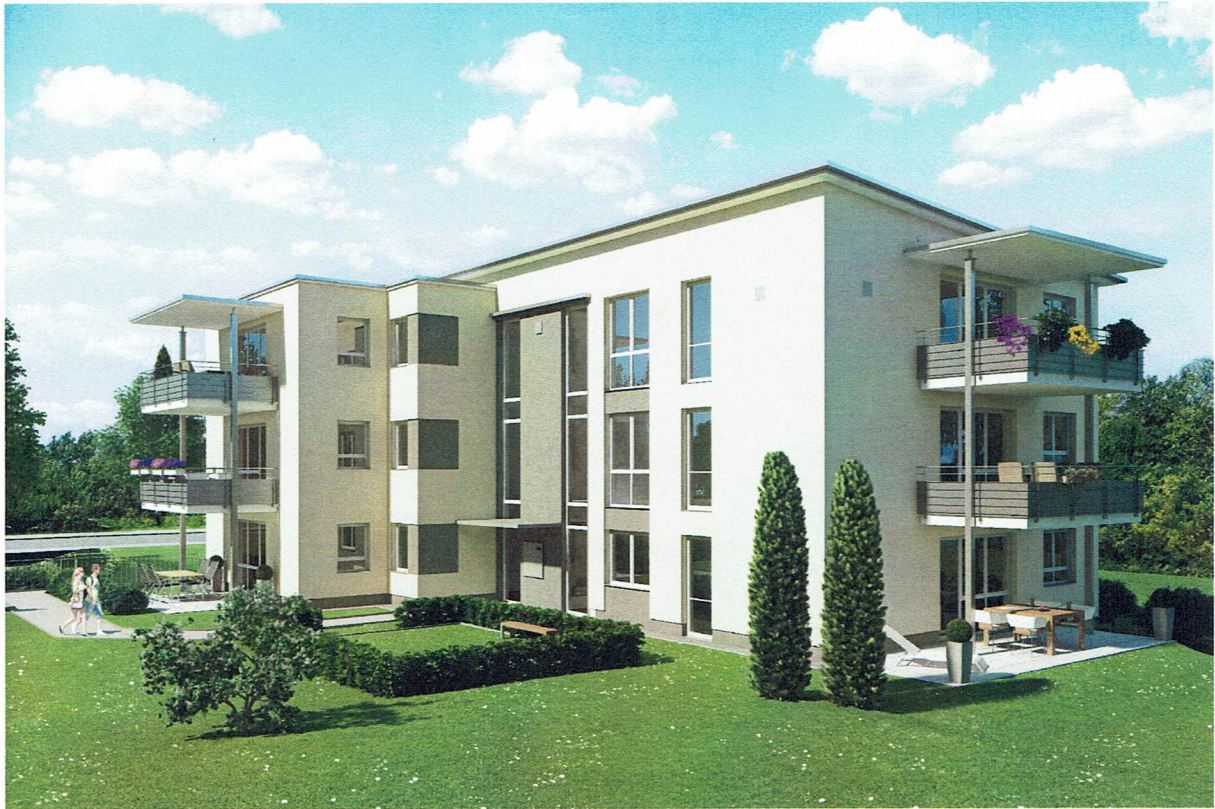
Haus 2: Süd-West Ansicht
