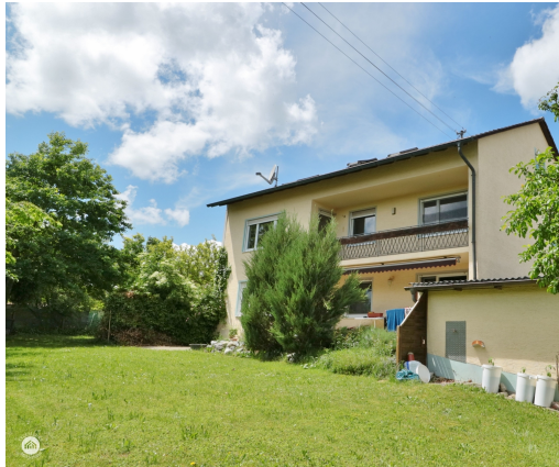
Zur Wohnung im 1. Obergeschoss
