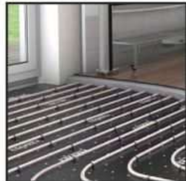
Fußbodenheizung
