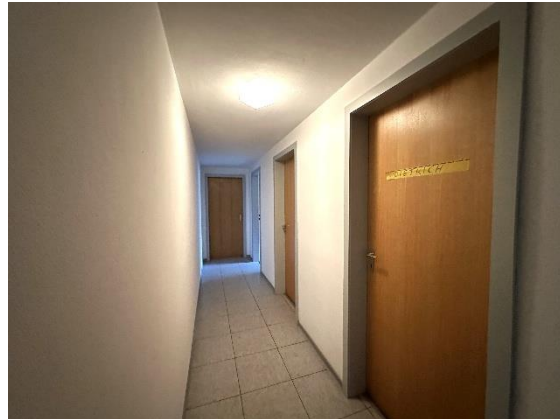
... Kellerräume der Mieter
