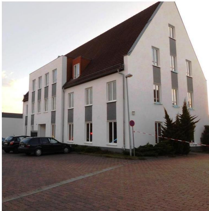
Ansicht Strassen + Parkplatzseite
