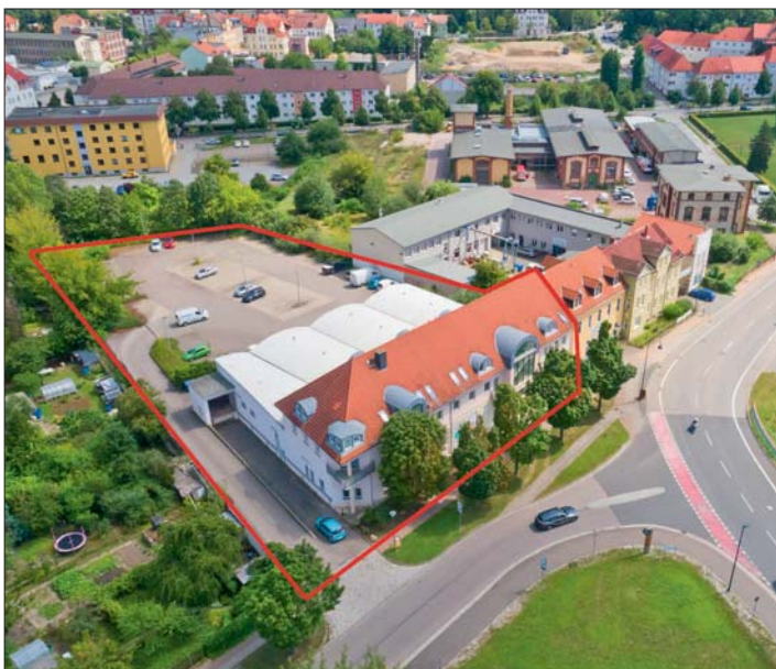
Wohn- und Geschäftshaus in Naumburg, Roßbacher Straße 9, 9a, 9b, Pos. 31
