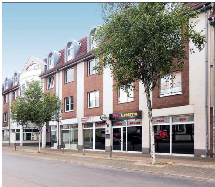
Büro- und Geschäftshaus in Schönebeck (Elbe), Böttcherstraße 50-52, Pos. 32
