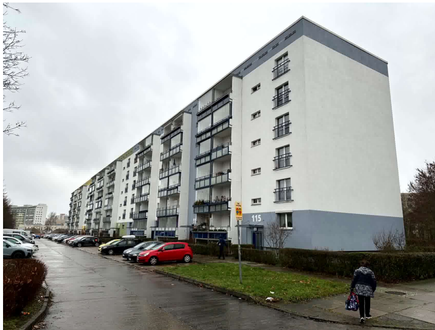
Bild 1: Straßenansicht, Hellersdorfer Straße 93-115 (ungerade)
