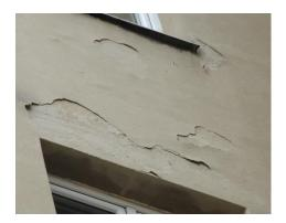
Aufgrund des aktuellen Zustandes und der damit verbundenen Haftungsgefahr wurde Firma Santrofix mit Sofortmaßnahmen (Abschlagen lockerer und absturzgefährlicher Fassadenteile) an der hofseitigen Fassade beauftragt.
