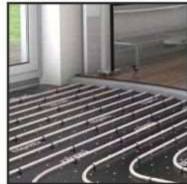
Fußbodenheizung
