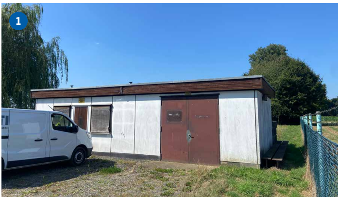
Bild 1: Büro/Werkstatt Bild 2: Pumpenhaus Bild 3: Tanklager
