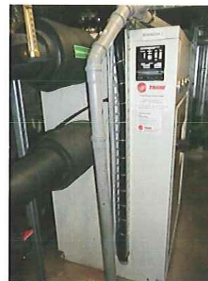
Abbildung 4 Kältemaschine 2, BJ 2008, 36kW
