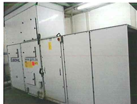
Abbildung 4 Kältemaschine 2, BJ 2008, 36kW
