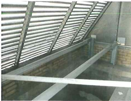
Abbildung 13 Zentraler Abluftschacht
