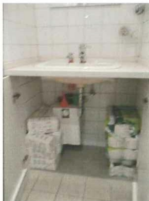
Abbildung 15 Untertisch-Kleinspeicher
