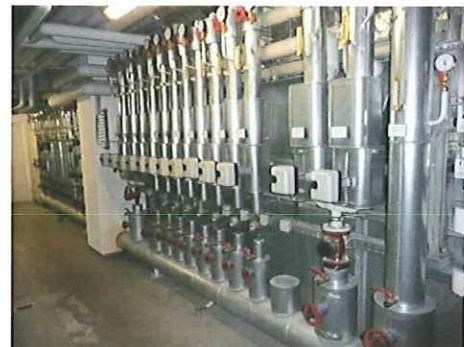
Abbildung 2 Wärmeverteilung RLT-Anlage
