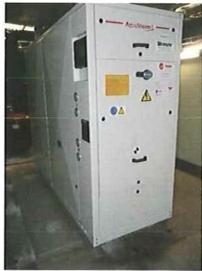
Abbildung 3 Kältemaschine 1, BJ 2012, 54kW
