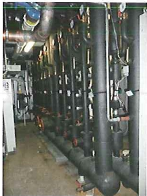
Abbildung 5 Verteilung Kälte
