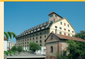
Bestandsfoto aus 06-2006 vor der Sanierung
