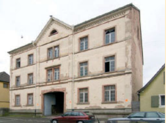
Bestandsfoto 2006 vor der Sanierung
