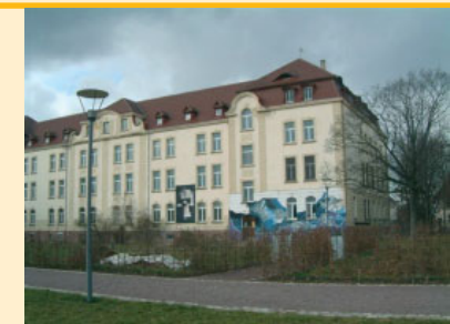
Bestandsfoto aus 12-2003 vor der Sanierung
