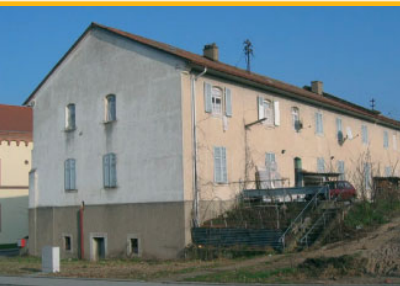
Bestandsfoto aus 12-2004 vor der Sanierung
