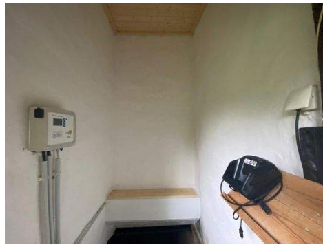
Schalter Biokläranlage
