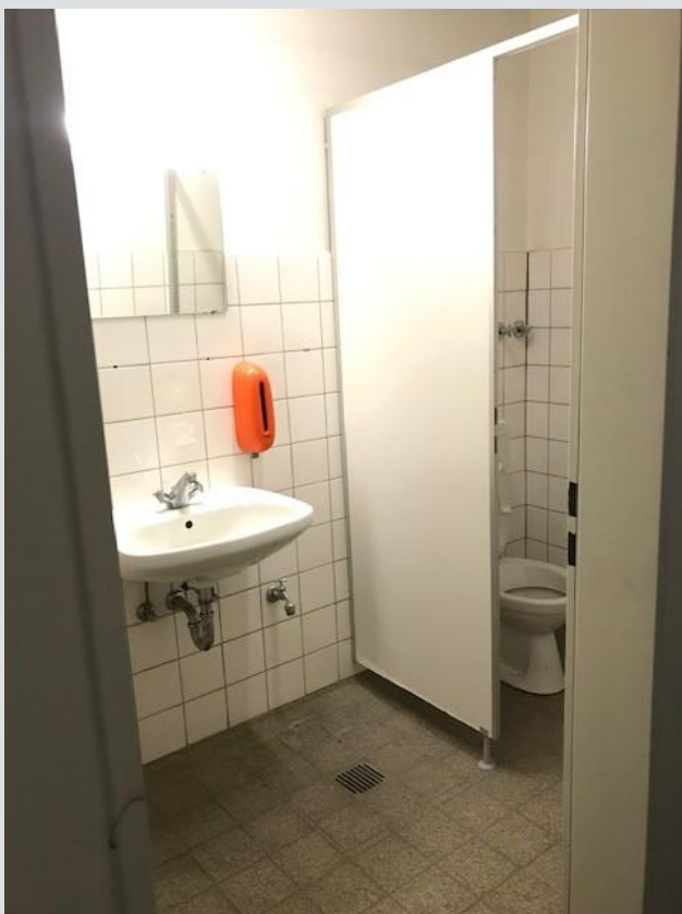
Badezimmer Damen (Bildrechte: Sprinkenhof GmbH)
