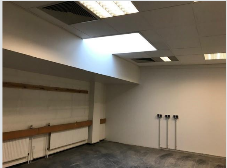
Raum mit Lichtkuppel (Bildrechte: Sprinkenhof GmbH)
