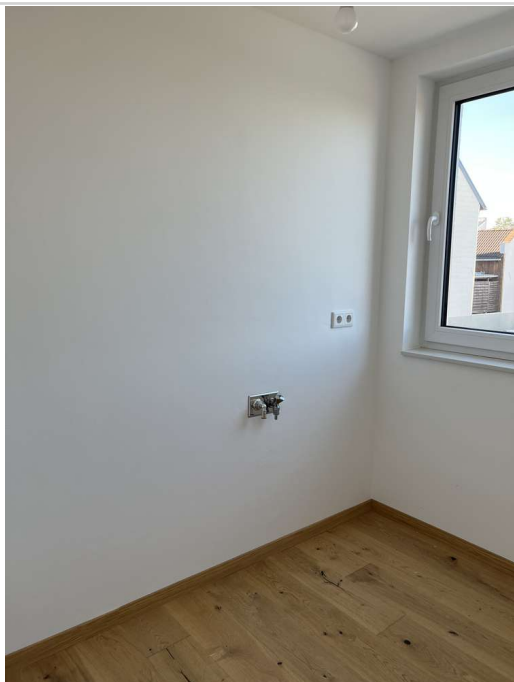
Waschmaschinenanschluss
