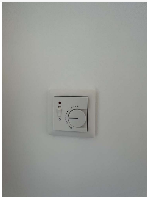
Raumregelung Fußbodenheizung
