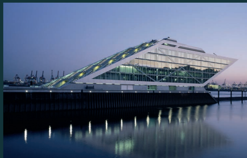
Dockland Bürogebäude Hamburg, 2006
