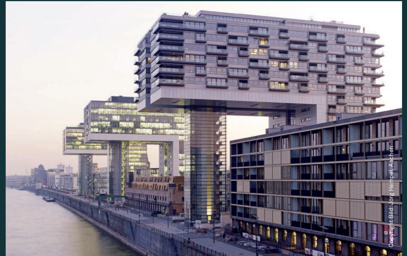
Kranhäuser Büro- und Wohngebäude Köln, 2010
