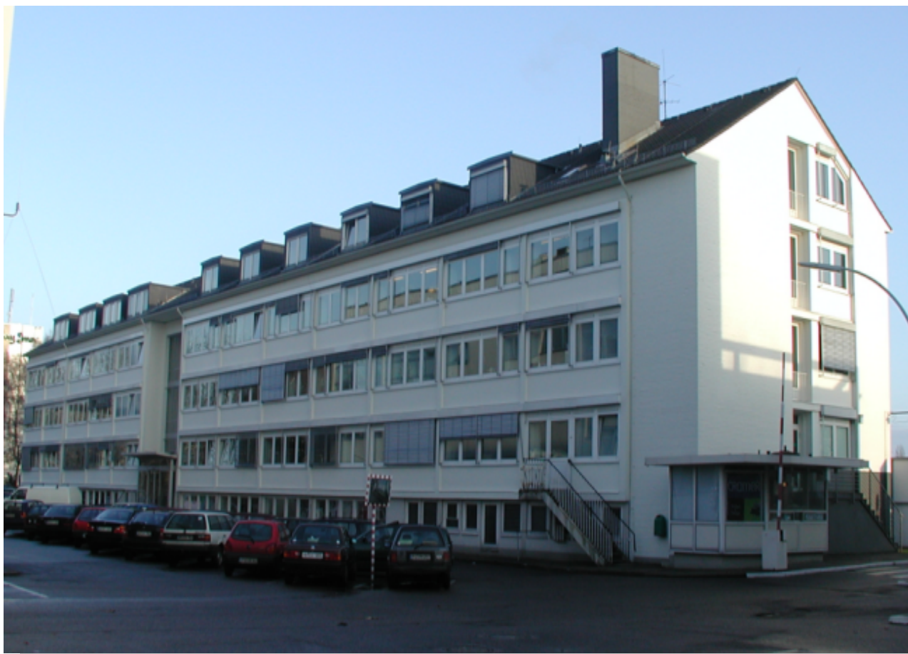
Ansicht Hofseite mit Parkplätzen
