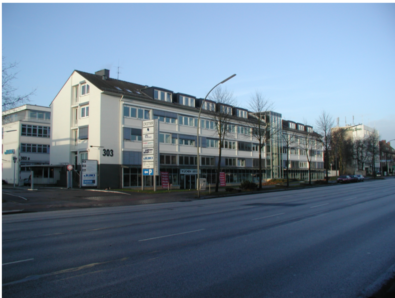
Südansicht Kieler Straße 303
