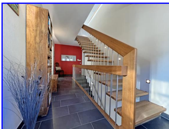
Massivholztreppe mit Edelstahlgeländer
