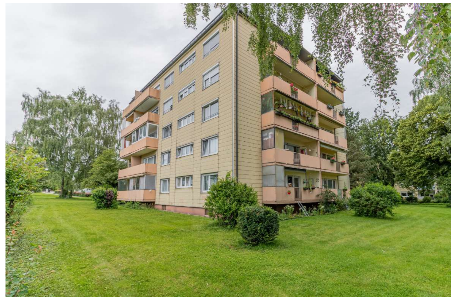
Ihr neues Zuhause in einer gepflegten Wohnanlage
