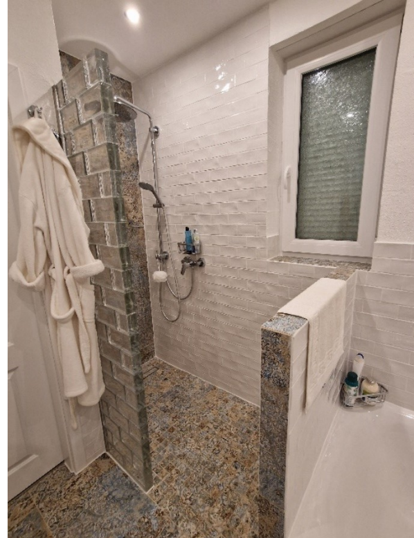
Bad en Suite große Dusche, die Glasbausteine können beleuchtet werden.
