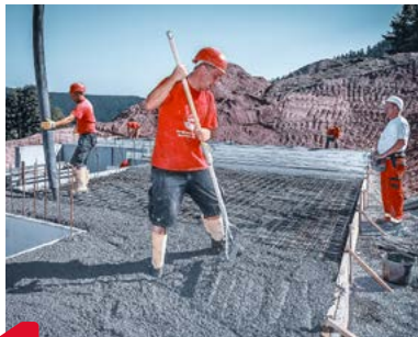
1 Betonieren der Bodenplatte
