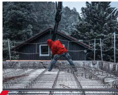
6 Betonieren des Kellers
