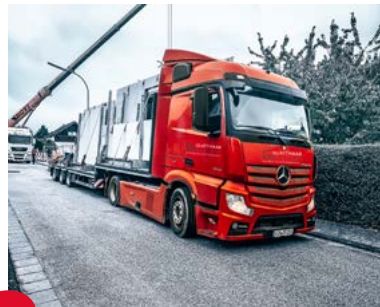
2 Entladen der Fertigteile
