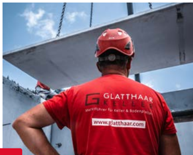
5 Verlegen der Deckenelemente
