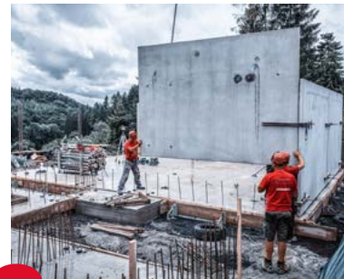
3 Stellen der Aussenwände
