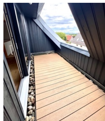
DG Nord - Terrasse
