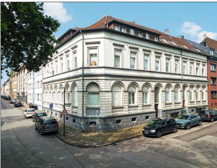
Mehrfamilienhaus in Gelsenkirchen OT Bulmke-Hüllen , Pos. 17
