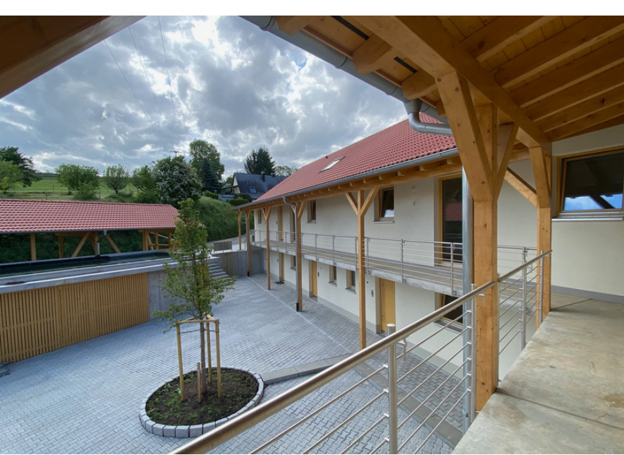
Blick vom Laubengang in den Innenhof
