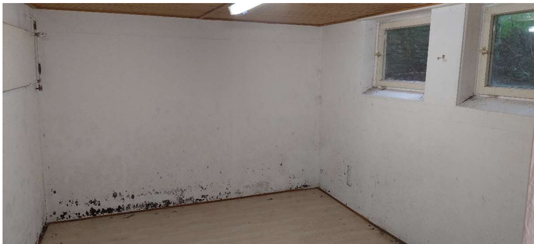
© IMBY Kellerraum mit Schimmelbefall
