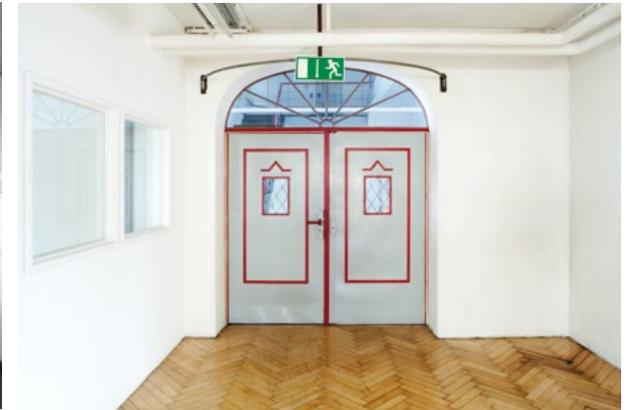
Brandschutztür zwischen den Gebäudeteilen
