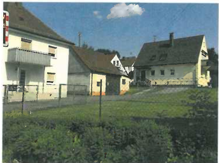
Blick von Norden auf die Bestandsbebauung an der "Ortsstraße"
