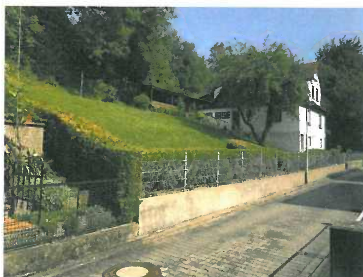
Blick von Westen auf den Hongbereich om "Pfarrer- Moog-Weg"
