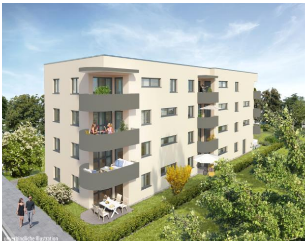
unverbindliche Illustration Bauvorhaben Gerlingen Schillerstraße 26 unverbindliche Illustration
