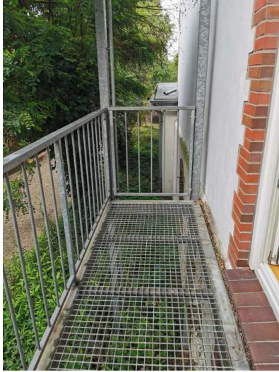
Balkon- und Terrassenzugang vom Wohnzimmer aus
