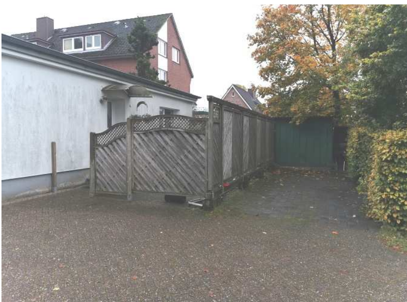
Hinterer Anbau Bild 5
