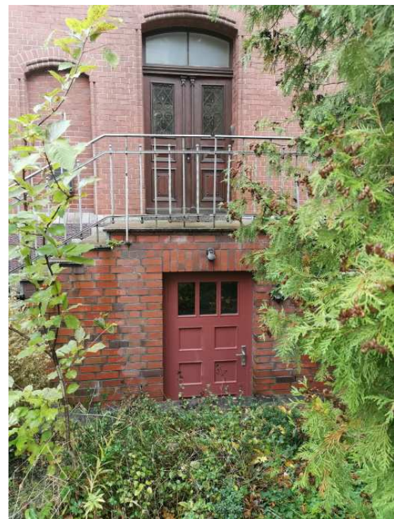
Eingangstür Vorderhaus Und Kellerzugangstür
