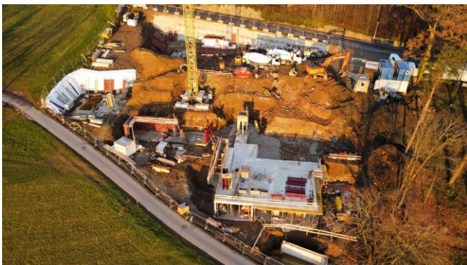
Baufortschritt vom Dezember 2024
