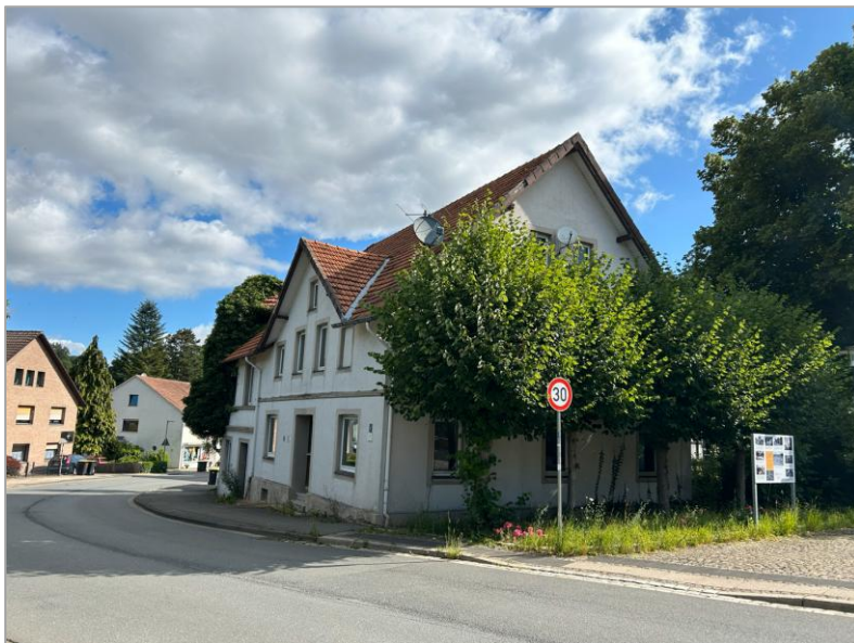
Einmündung „Am Tie“
