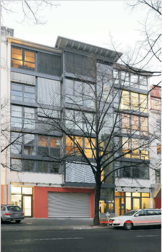
Neubau in der Baulücke zwischen Ludwigstraße 21 und Ludwigstraße 23, 2007
