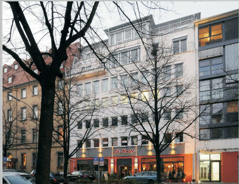
Modernisiertes Gebäude Ludwigstraße 21 mit Aufstockung um zwei Staffelgeschosse, 2007
