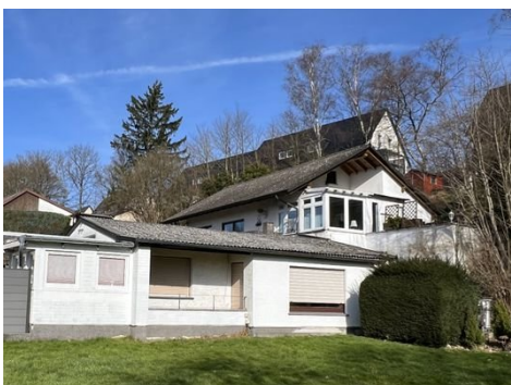
Haus 2: Ansicht Bungalow
