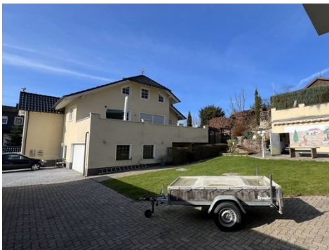
Haus 1: Ansicht Einfamilienhaus
