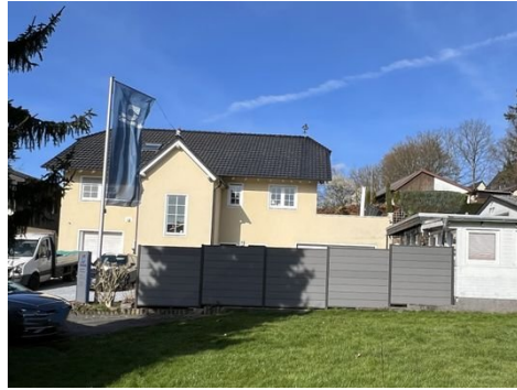
Haus 1: Ansicht Einfamilienhaus
