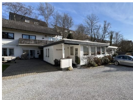
Haus 2: Ansicht Bungalow
