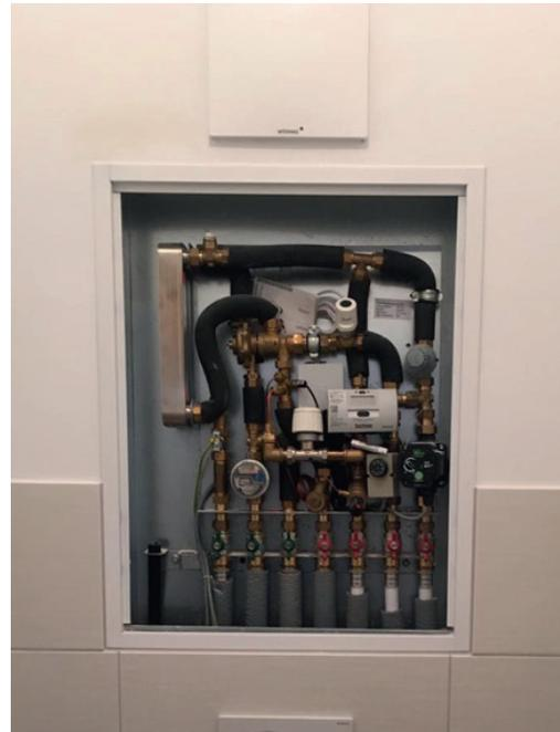
In jeder Wohnung befindet sich ein Heizungsverteiler für die Fußbodenheizung inkl. Wärmemengenzähler.
