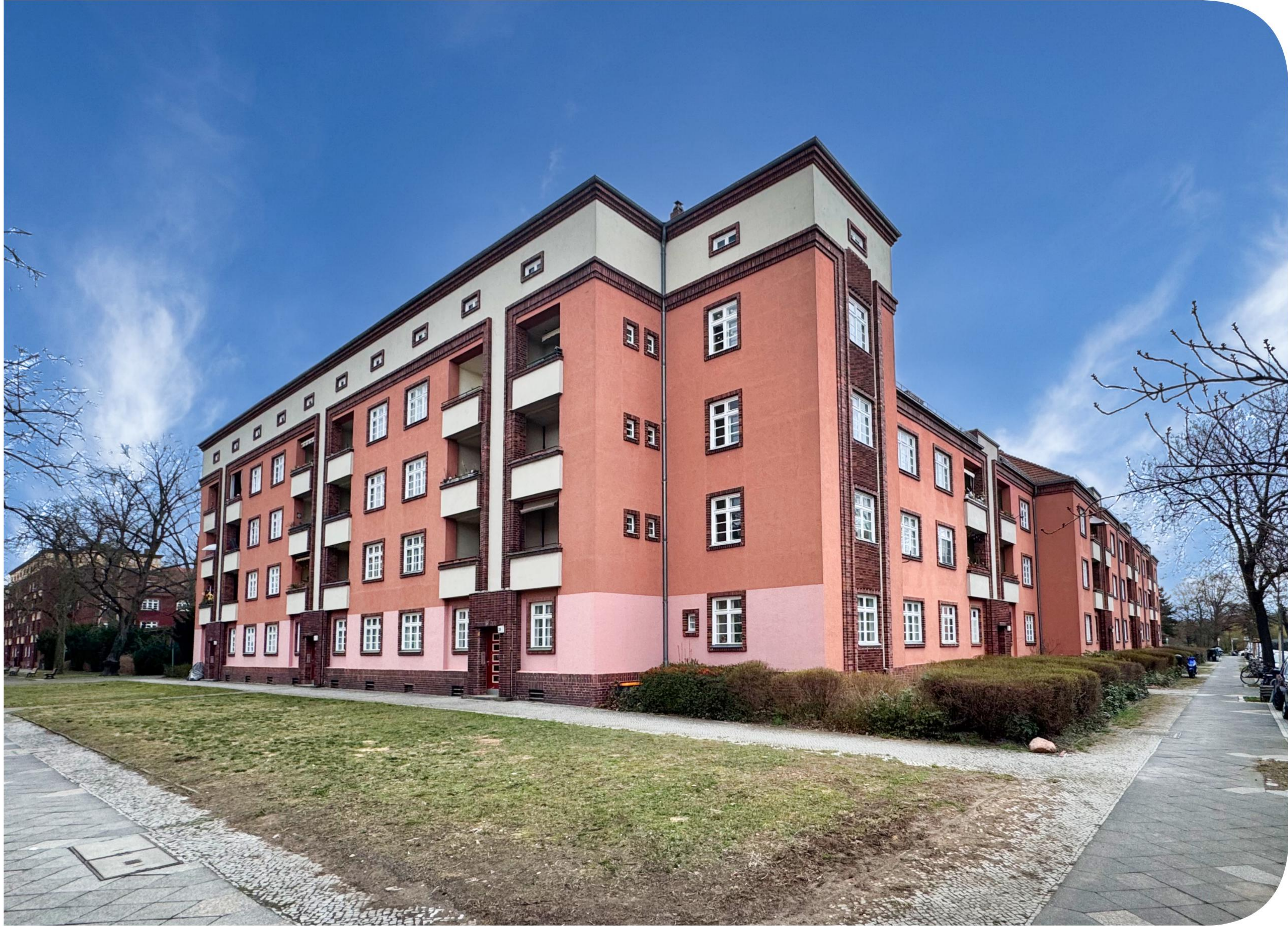
SEITENANSICHT GEBÄUDE RECHTS
