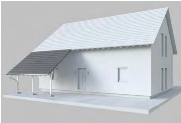
Carport mit Dachabschleppung
