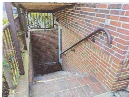
Außentreppe zum Keller
