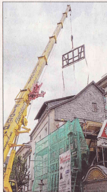
Mit einem 40-Meter-Kran werden die Gewerke an ihren künftigen Platz gehoben. FOTO: HOMANN
