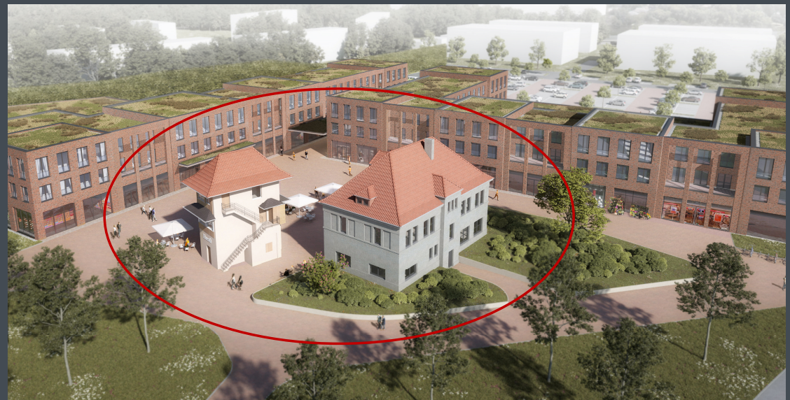
rot umrandet: Stellwerk (links) und BASA-Gebäude
