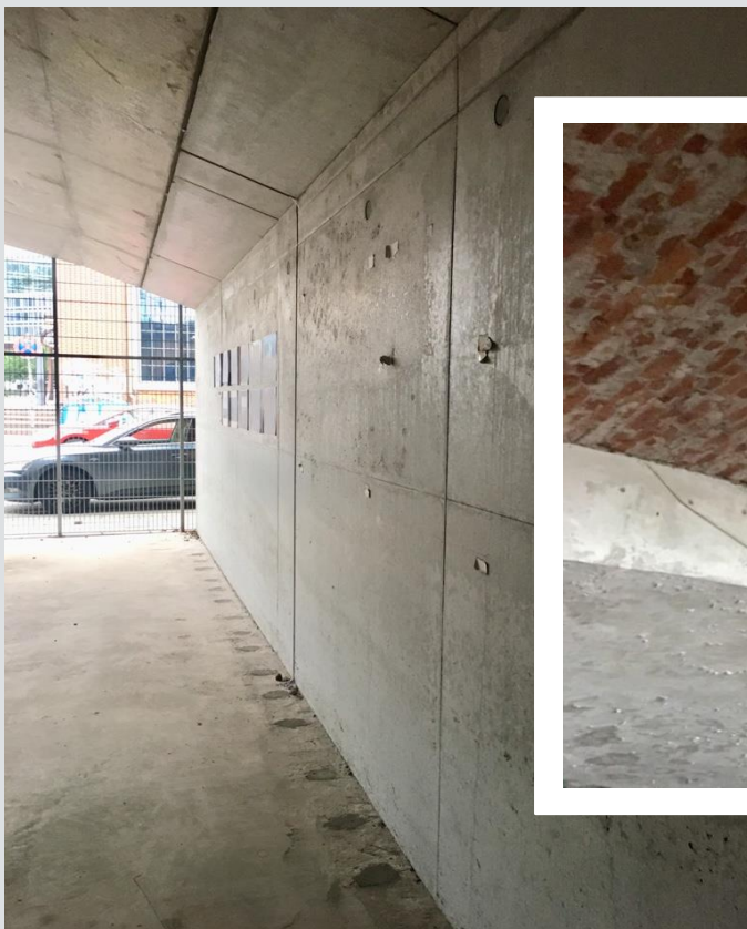
Mauerwerksmäßige Sanierung ca. 30 cm starke Betonversteifung
