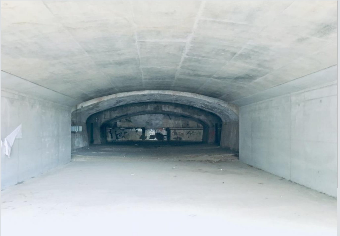
Mauerwerksmäßige Sanierung ca. 30 cm starke Betonversteifung
