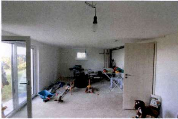
Ansicht Beispiel Kellerraum
