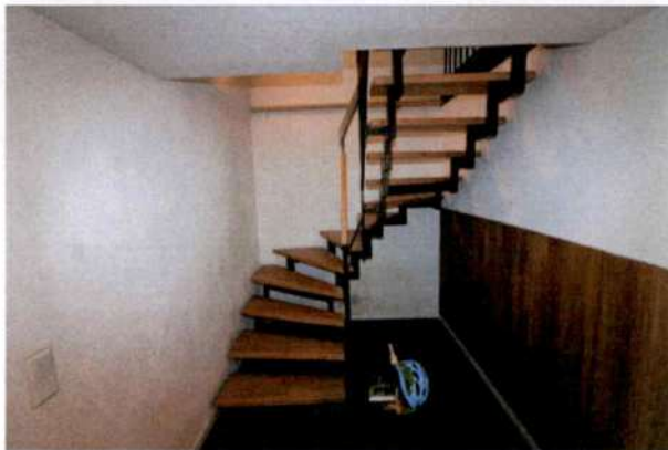
Ansicht Treppenaufgang Kellergeschoss
