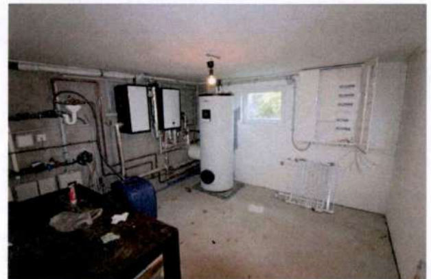
Ansicht Beispiel Kellerraum
