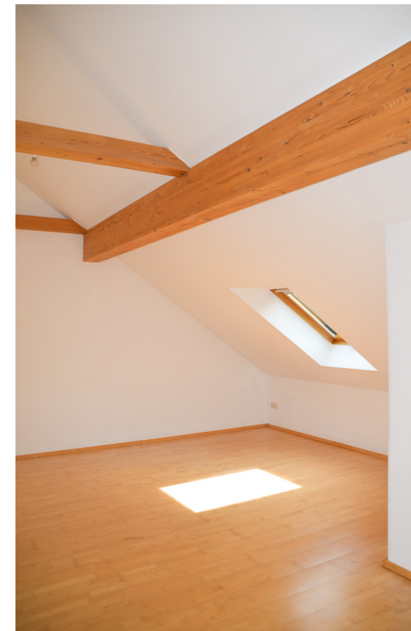
Dachkonstruktion mit offenen Holzbalken
