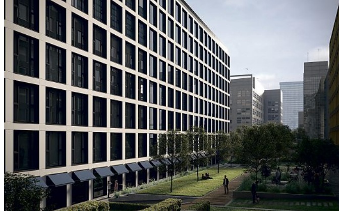
DER NAMENSGEBENDE HOF DES M-YARD BIETET VIEL FREIFLÄCHEN ZUM ENTSPANNEN. VISUALISIERUNG: FIDUCIARY CAPITAL GMBH
