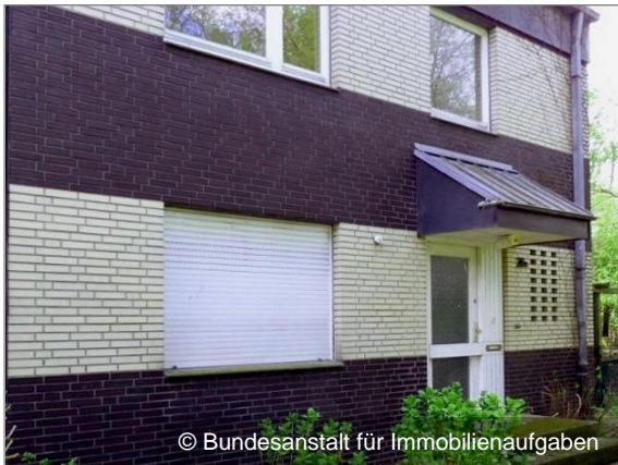
Nordansicht, Hauseingang u. Küchenfenster
