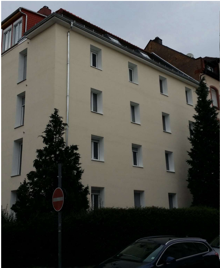
FI24 Fasade B04
