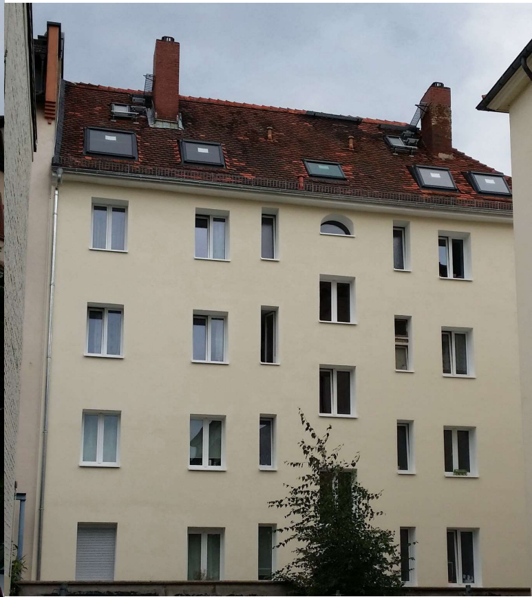
FI24 Fasade B05
