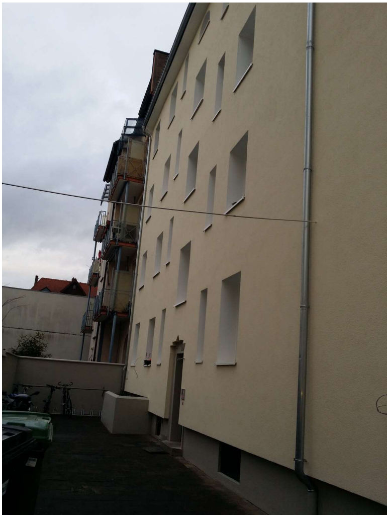
FI24 Fasade B06
