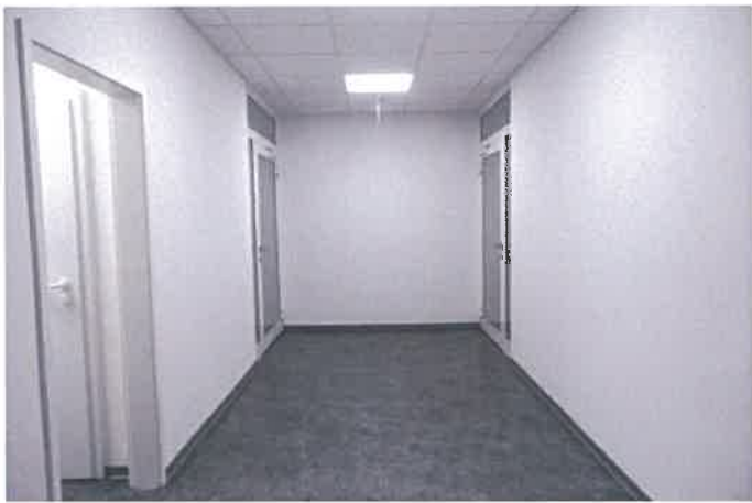
Vorraum mit WC-Anlage zu den Büroflächen
