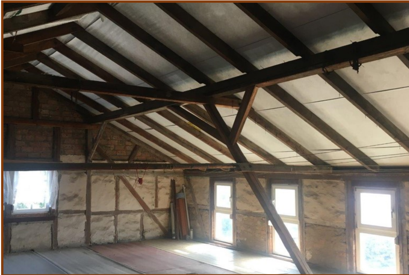
Hinterhaus – ausbaufähiges Dachgeschoss
