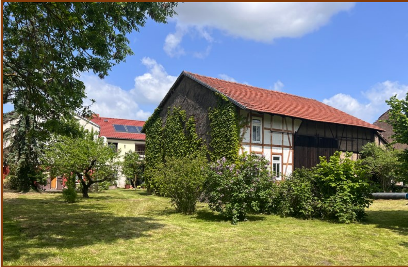
Scheune – Ansicht von Süd-Westen
