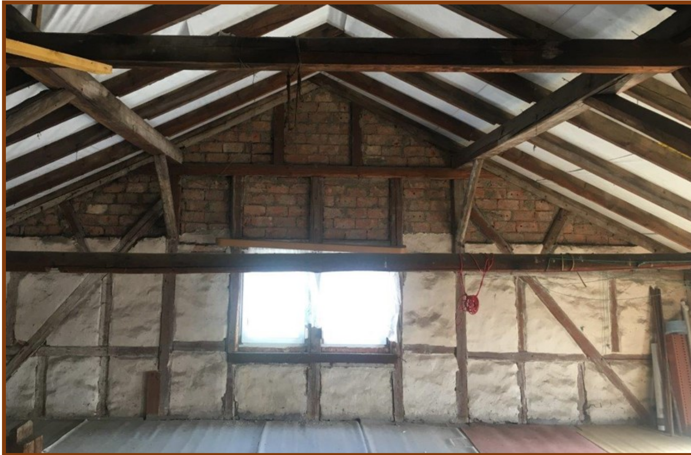
Hinterhaus – ausbaufähiges Dachgeschoss
