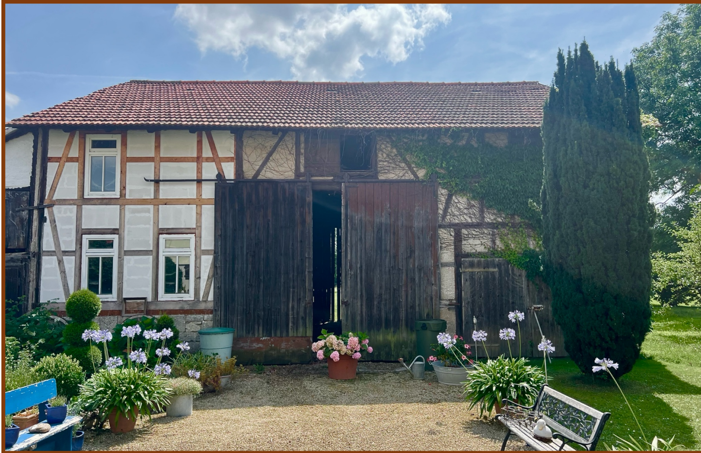
Scheune – Ansicht von Norden
