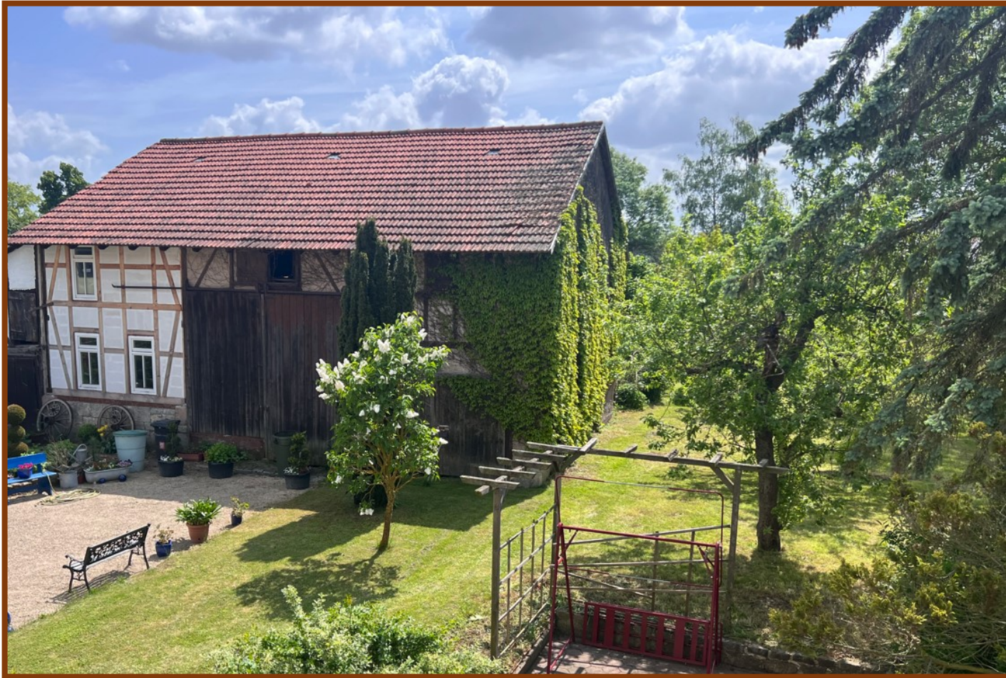
Scheune – Ansicht von Norden
