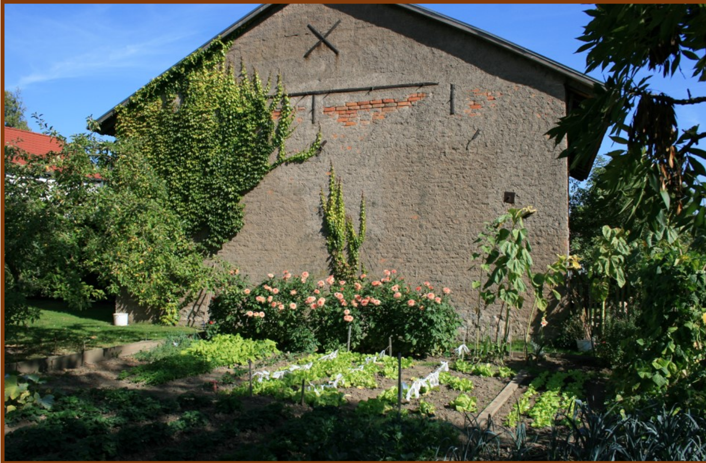
Scheune – Ansicht von Westen
