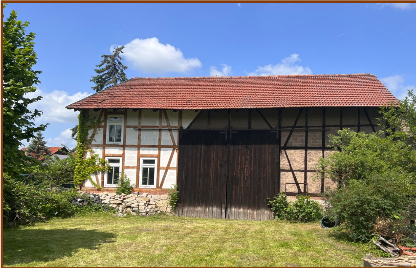
Scheune – Ansicht von Süden
