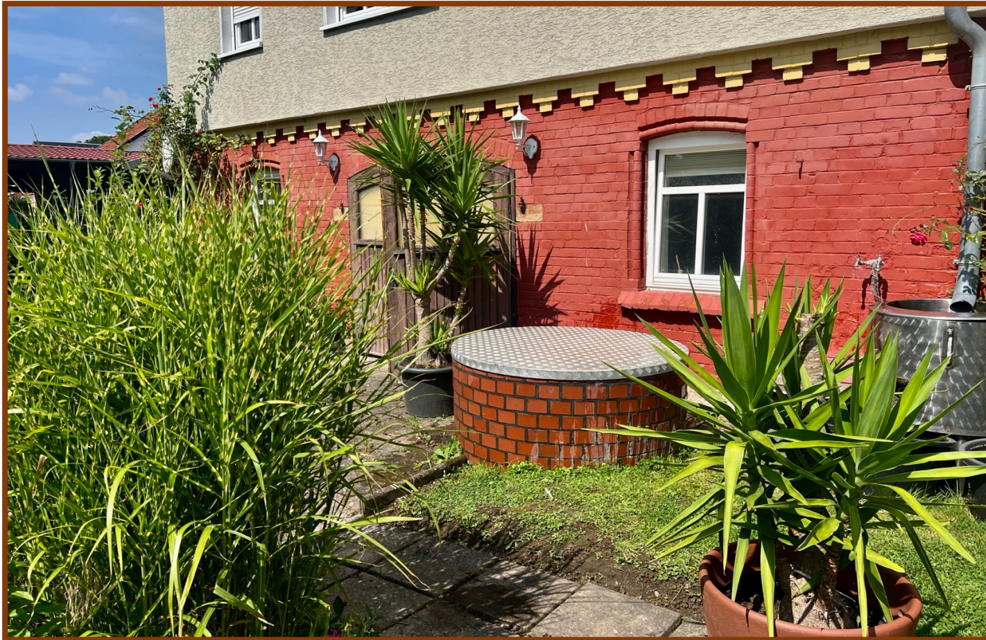
Hinterhaus – Fassade Erdgeschoss mit Brunnen
