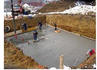
Sohlenbetonage
