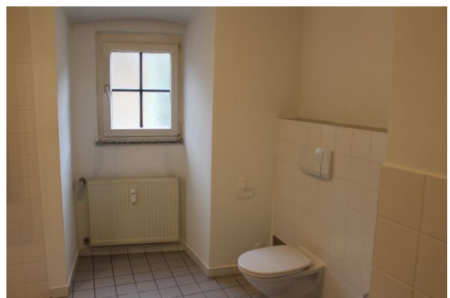
Fenster im Bad
